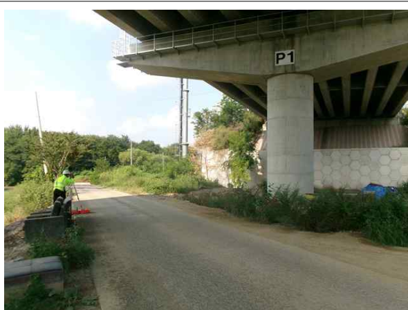
광파기를 이용한 측량 작업
